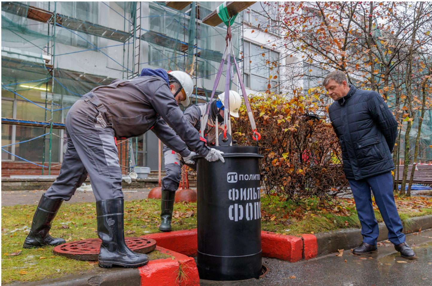
Установленный фильтр заполнен перспективным сорбционным материалом на основе печной окалины. В ходе испытаний предстоит подтвердить возможность использования данного материала в процессах удаления тяжёлых металлов и фосфора из поверхностных сточных вод. Использование печной окалины в качестве сорбента позволит расширить возможности утилизации данного отхода металлургической промышленности.
